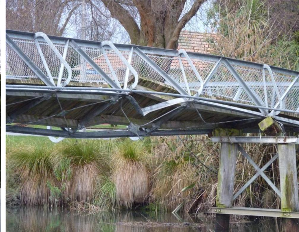
Flambement d'une passerelle piétonne sur la rivière Avon à Christchurch (l'augmentation de la charge axiale de compression est due à un glissement de terrain qui provoqua le déplacement de la culée).
