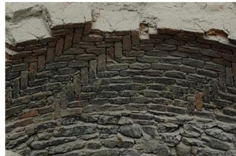
De plus, on retrouve des chaînettes, localement, dans chaque pan du dôme : les lits de brique ne sont en réalité pas sur le même plan, ils forment une parabole vers le bas, comme un caténaire sous son poids propre. En traction, cette forme permet sans doute d'équilibrer la poussée des contreforts, de la même façon que le tissu tendu d'un parapluie empêche les baleines de trop s'ouvrir.
