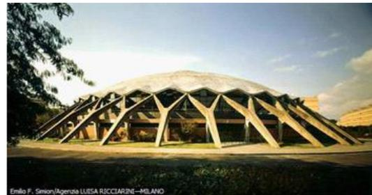
Enfin, pour éviter le **voilement** (flambement des surfaces comprimées), on utilise les mêmes techniques que pour les voûtes. Par exemple, dans le Palais des Sports de Rome de Nervi, on retrouve les nervures qui lui sont chères. La coupole du CNIT est, elle, réalisée par une double coque très mince et plissée. Enfin, Il est également possible de réduire la longueur de flambement en rajoutant des anneaux horizontaux, sur le modèle du tabouret de bar.
