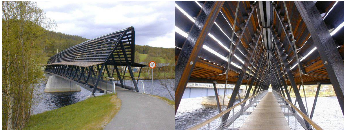
Photos de la passerelle réelle
